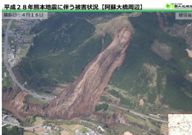
写真7 熊本地震の土砂災害により、孤立地域が発生（2016年4月）
