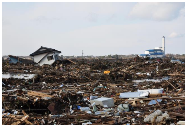
写真5 東日本大震災の津波により宮城県山元町が孤立化（2011年3月）
