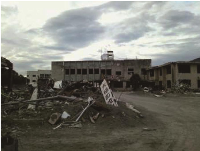
写真1 2011年3月の東日本大震災での津波で全壊した岩手県大槌町役場庁舎
