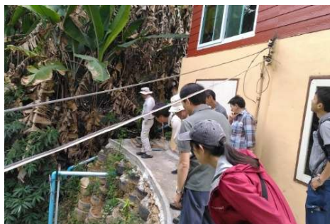
崩落発生箇所
