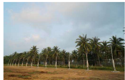
VHFレーダー(アンテナ)の外観
