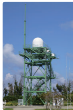
フェーズドアレイ気象レーダー Phased array weather radar
