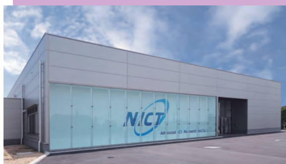
神戸クリーンルーム外観写真
