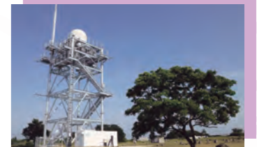
未来ICT研究所に設置されたPANDA鉄塔とコンテナ
