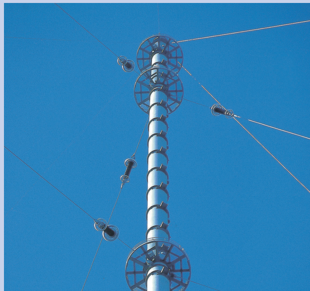
▲傘型アンテナ頂部
