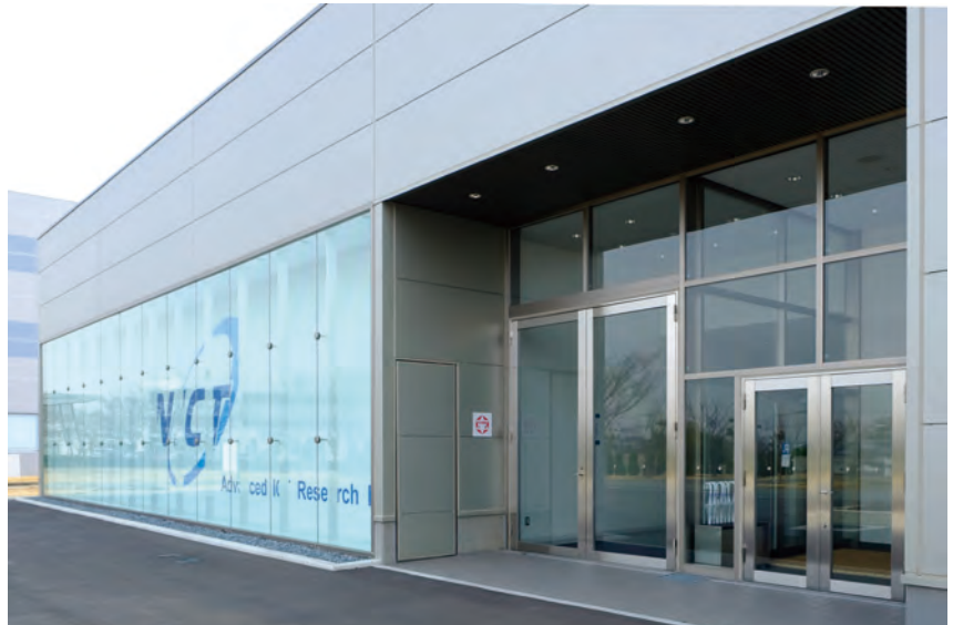
図2 新築されたクリーンルーム
