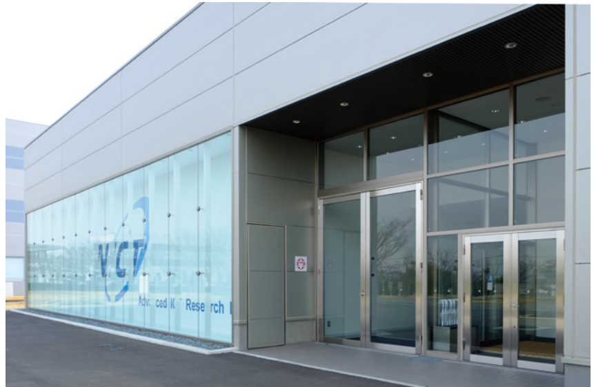
図2 新築されたクリーンルーム
